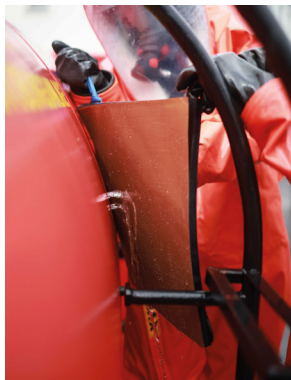
Heranführen an die Leckage
